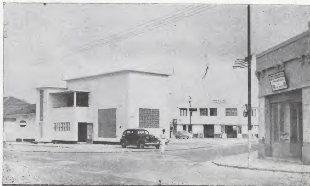
Entrada de San Nicolás, moderna población que progresa rápidamente debido a la numerosa colonia formada por miles de extranjeros trabajadores en la Lago.
